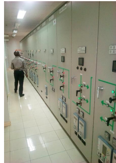
屋内用 33kV ガス絶縁開閉装置
