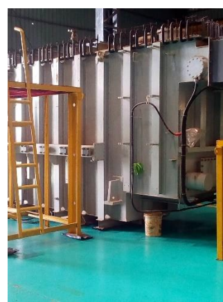
修理中の変圧器
